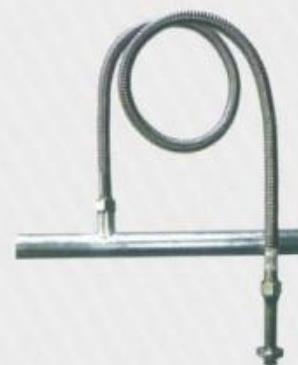
플렉시블 조인트 시공
